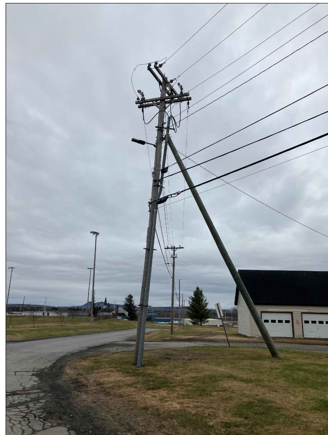
D1 EXISTING UTILITY POLE
