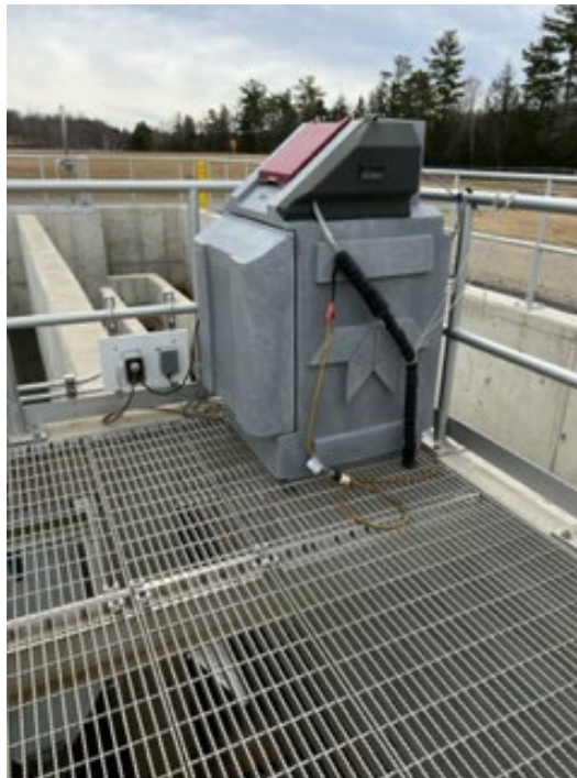
Effluent Sampler
